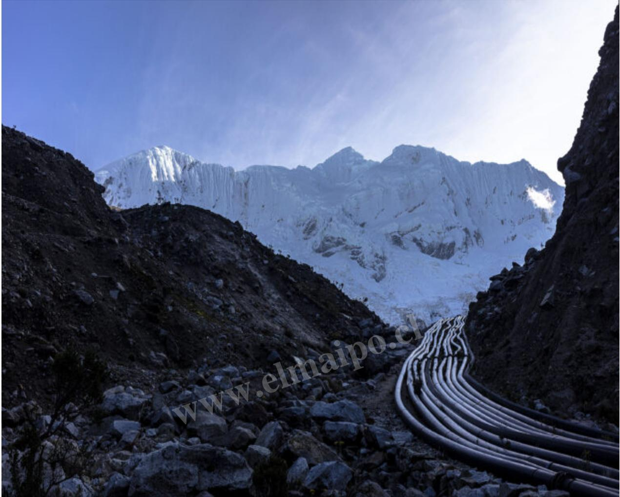
Tuberías provisionales extraen agua de la Laguna Palcacocha. Estas no serían suficientes para proteger la ciudad de una ola de inundación. Foto: Indira Palomino / Germanwatch
