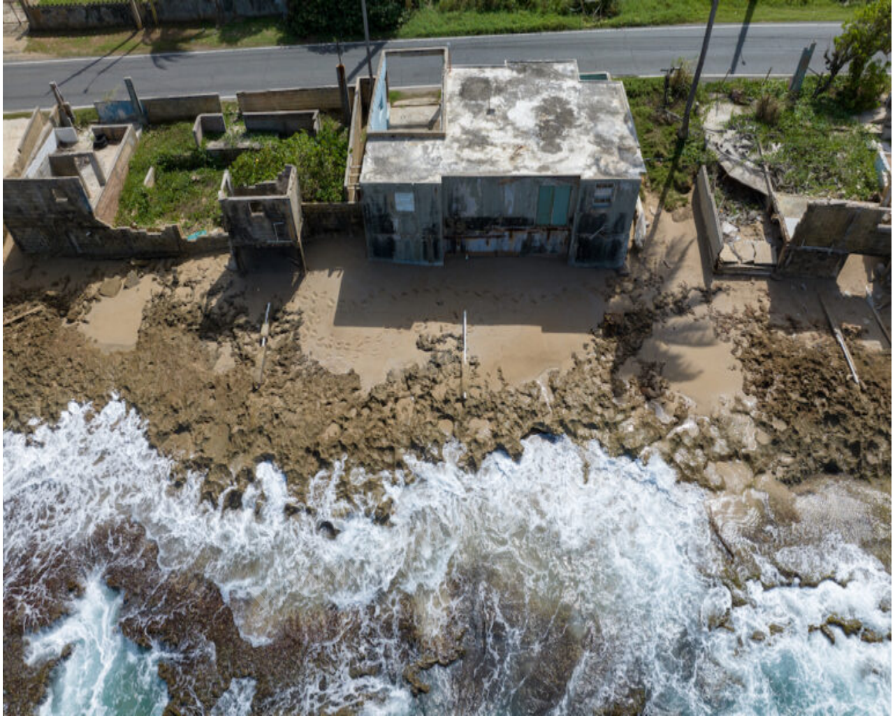
Obras de infraestructura que han provocado sinergia con el aumento del nivel del mar. Foto: Jorge Ramírez Portela
