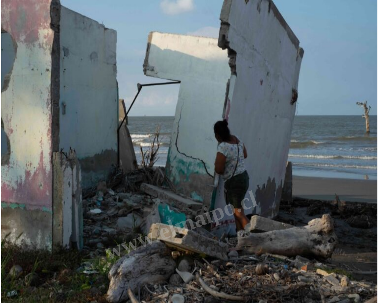
Una de las casas afectadas por la erosión costera que sufre El Bosque. Foto: Isabel Mateos
