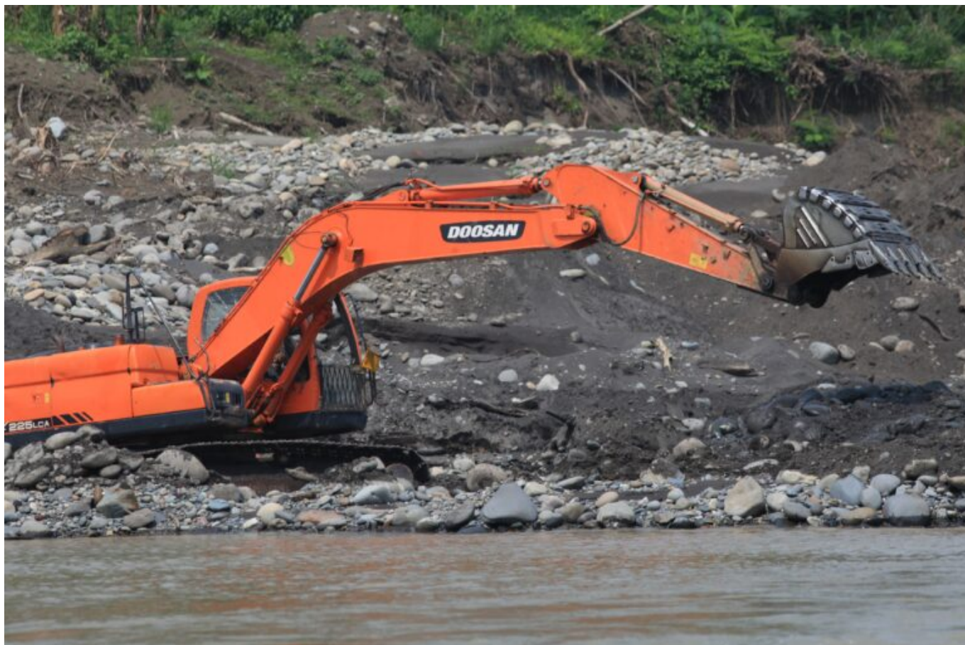
Una excavadora remueve la ribera del Santiago en búsqueda de oro. Foto: Armando Lara
