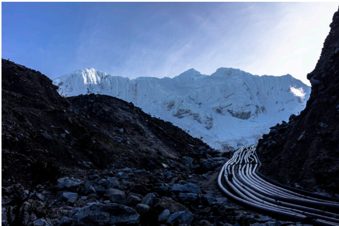
Tuberías provisionales extraen agua de la Laguna Palcacocha. Estas no serían suficientes para proteger la ciudad de una ola de inundación. Foto: Indira Palomino / Germanwatch
