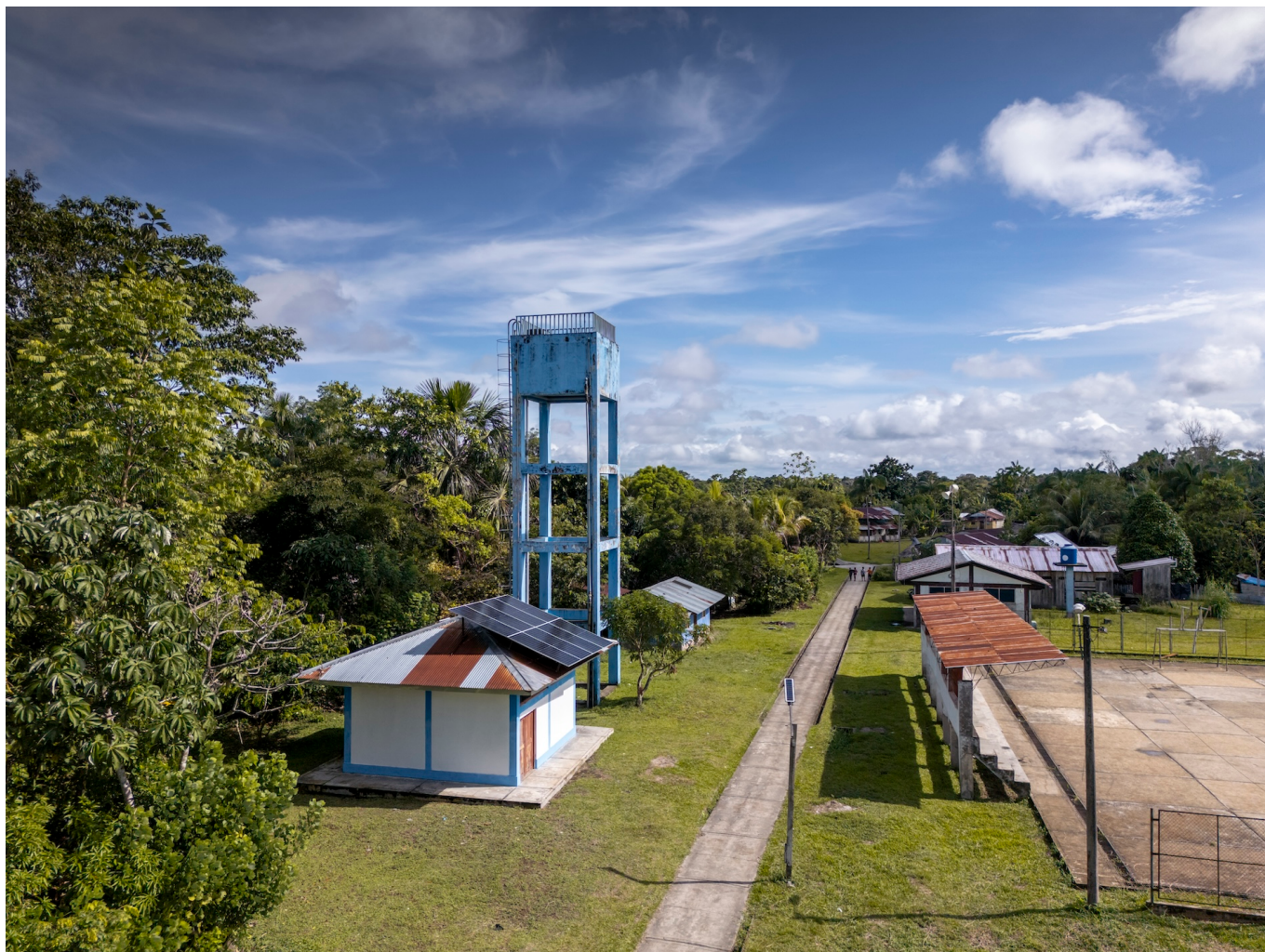
Panel solar instalado en otra de las comunidades del Ampiyacu. Foto: cortesía CI Perú
