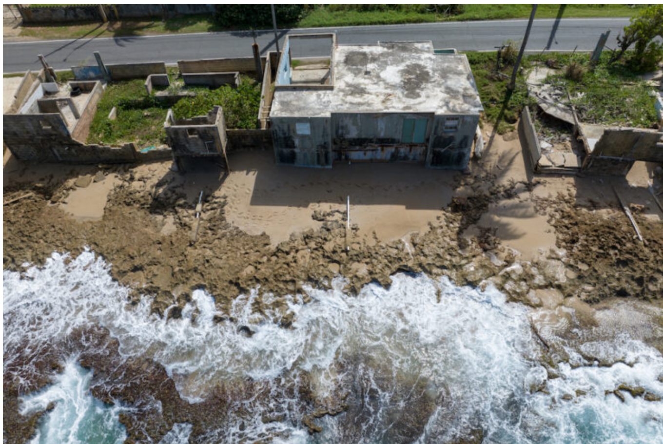
Obras de infraestructura que han provocado sinergia con el aumento del nivel del mar. Foto: Jorge Ramírez Portela
