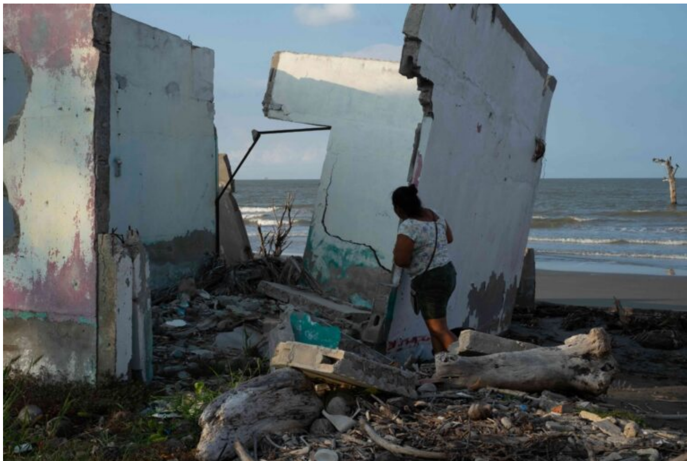
Una de las casas afectadas por la erosión costera que sufre El Bosque. Foto: Isabel Mateos
