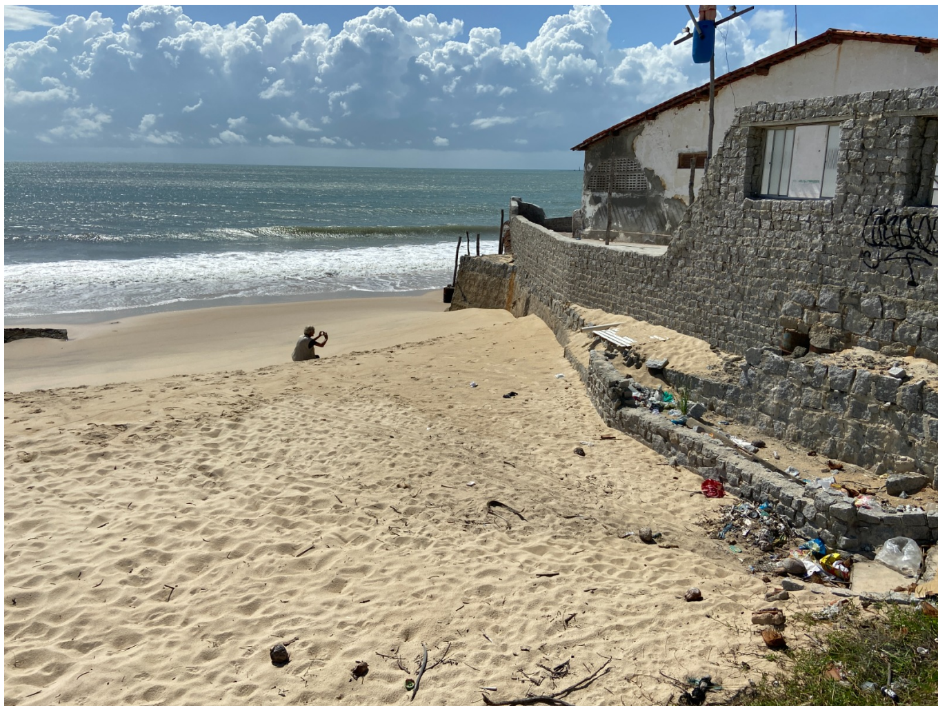
Impacto del avance del mar sobre las costas de Baía da Traição, donde las casas y la infraestructura están siendo invadidas. Foto: cortesía Saulo Roberto de Oliveira Vital
