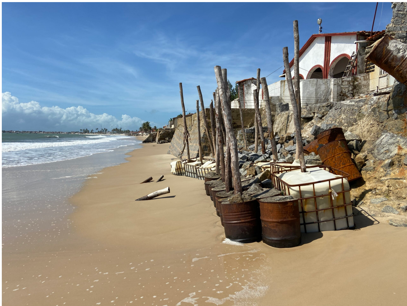
La erosión costera en Baía da Traição muestra cómo el mar está ganando terreno sobre las viviendas cercanas a la franja de arena. Foto: cortesía Saulo Roberto de Oliveira Vital
